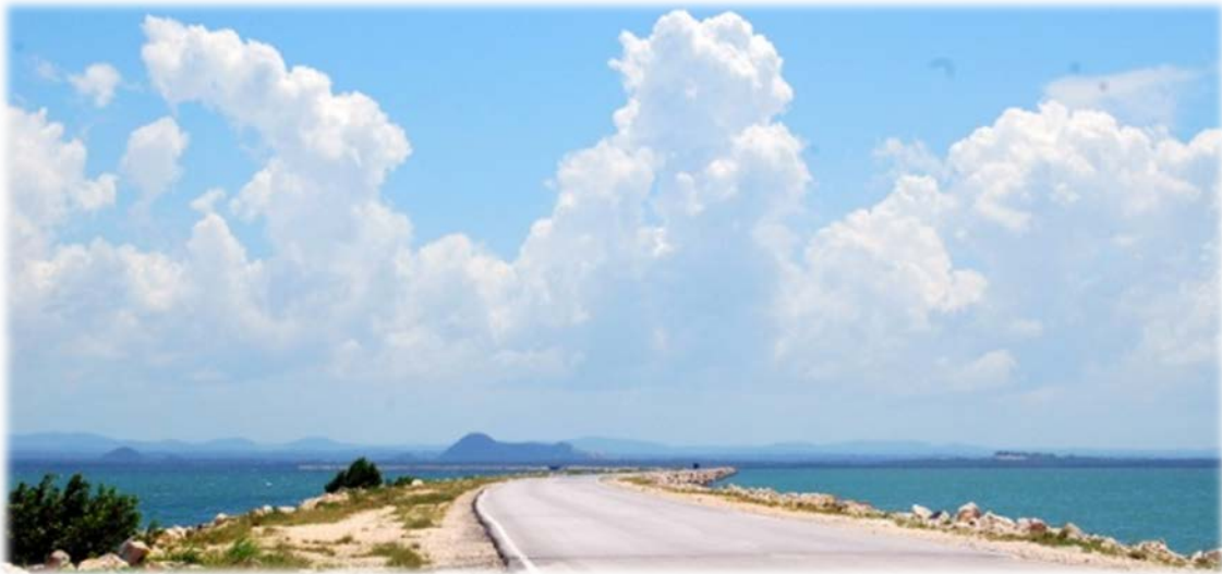
Pedraplén from Caibarién
